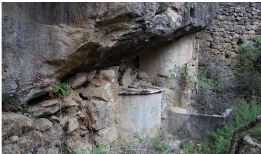
Fig. 7. Zona de almacenamiento del aceite, en la que, bajo el conjunto rocoso, todavía se conserva una pila tallada de una sola pieza en piedra de arenisca, y la pila de decantación. Autoría: Eugenio Monesma.
